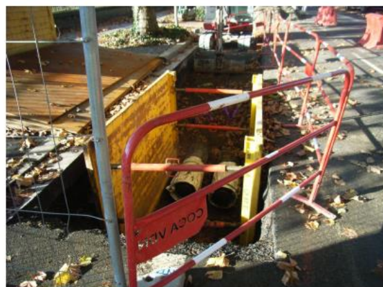
Réalisation d'une tranchée
